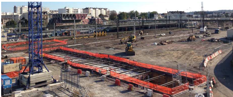
Premier tronçon du passage souterrain Nord prolongé, le 30 septembre 2015
