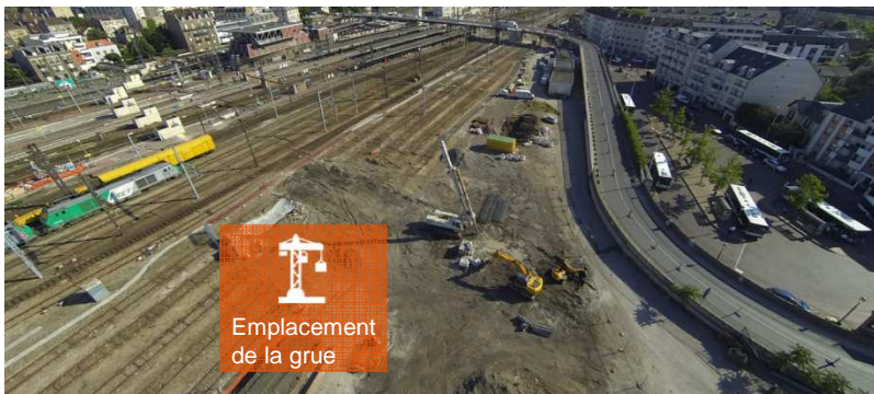
Vue général du chantier, côté Mairie - Crédit image : SNCF - AREP
